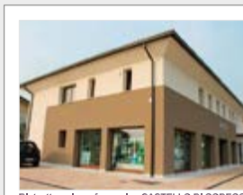
Ristrutturazione farmacia - CASTELLO DI GODEGO
