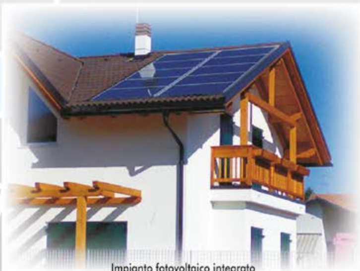
Impianto fotovoltaico integrato
