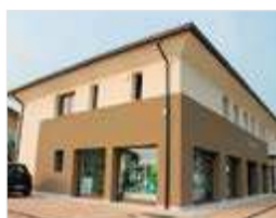
Ristrutturazione farmacia - CASTELLO DI GODEGO
