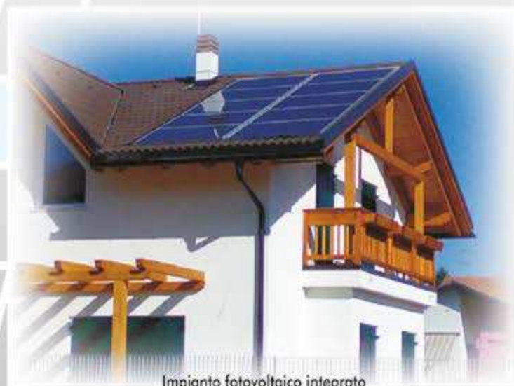
Impianto fotovoltaico integrato
